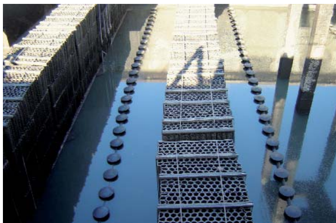
Аэротенки, оборудованные полимерной биозагрузкой и тарельчатыми аэраторами
