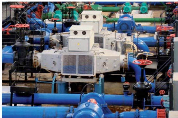
Ультрафиолетовые бактерицидные установки УДВ-500/72
